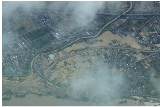
千曲川周辺の河川氾濫の様子
