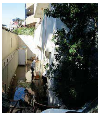
右：半地下居室があるマンション（弊社撮影）
