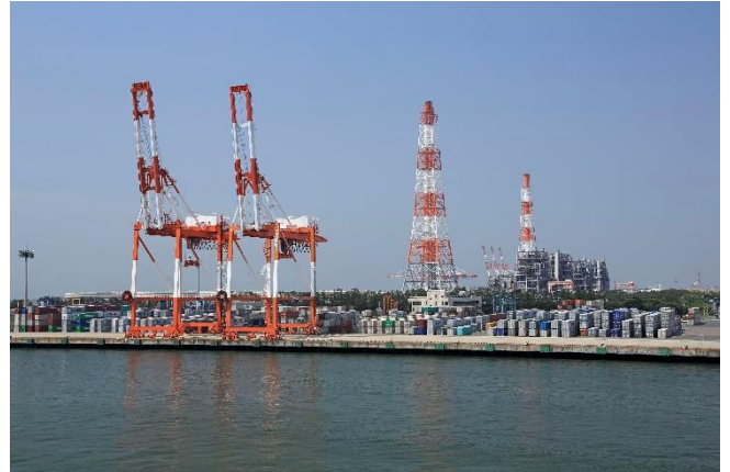
名古屋港コンテナターミナル 写真:後藤 昌美/アフロ
